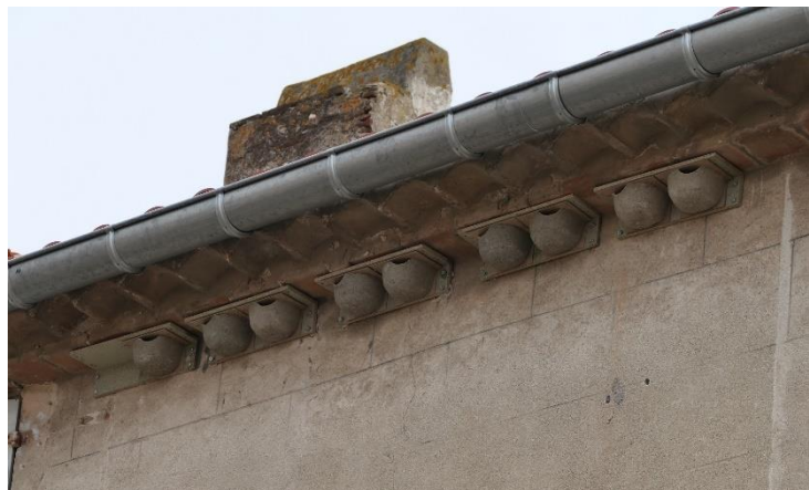
Figure 42 : Nichoirs à hirondelle de fenêtre, posés en façade sous l'avancée de la toiture (F. Olivier/GOR).
