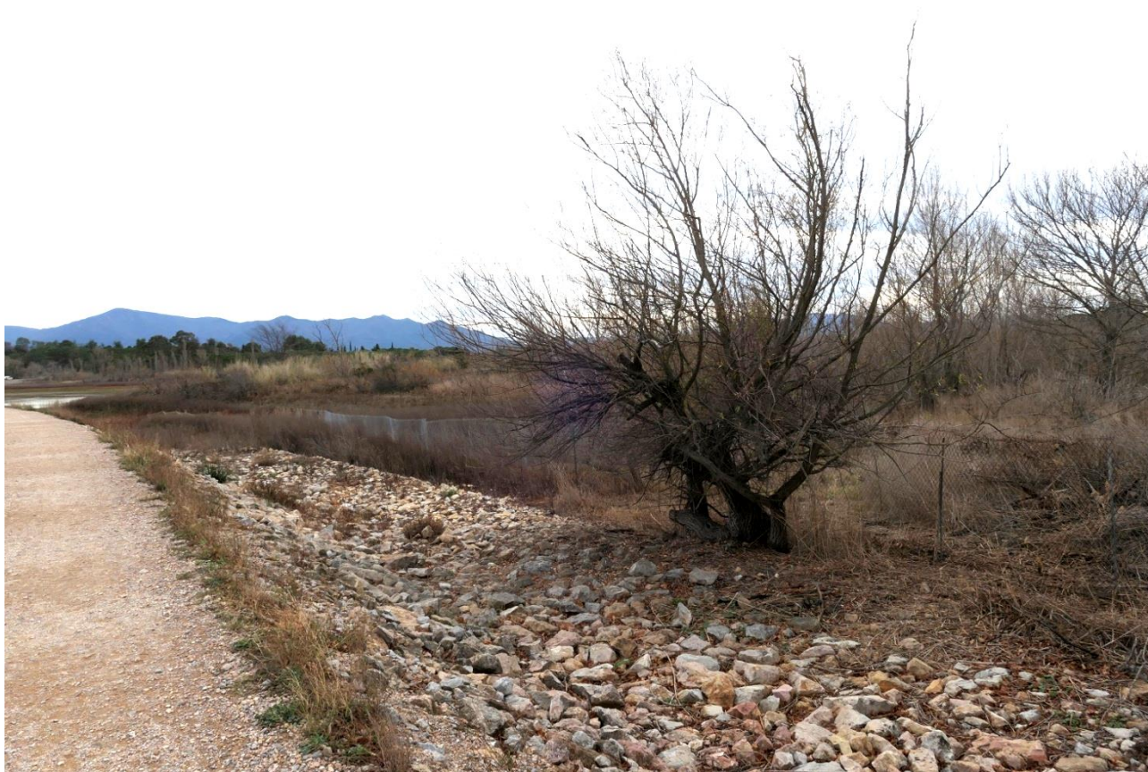
Réfection de la clôture de la réserve au niveau de la digue (Y. Aleman/GOR).
