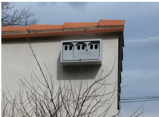
Photo 9 : Nichoir triple à Moineaux friquets, posé en façade à Laroque-les-Albères (A.Gaunet/GOR).
